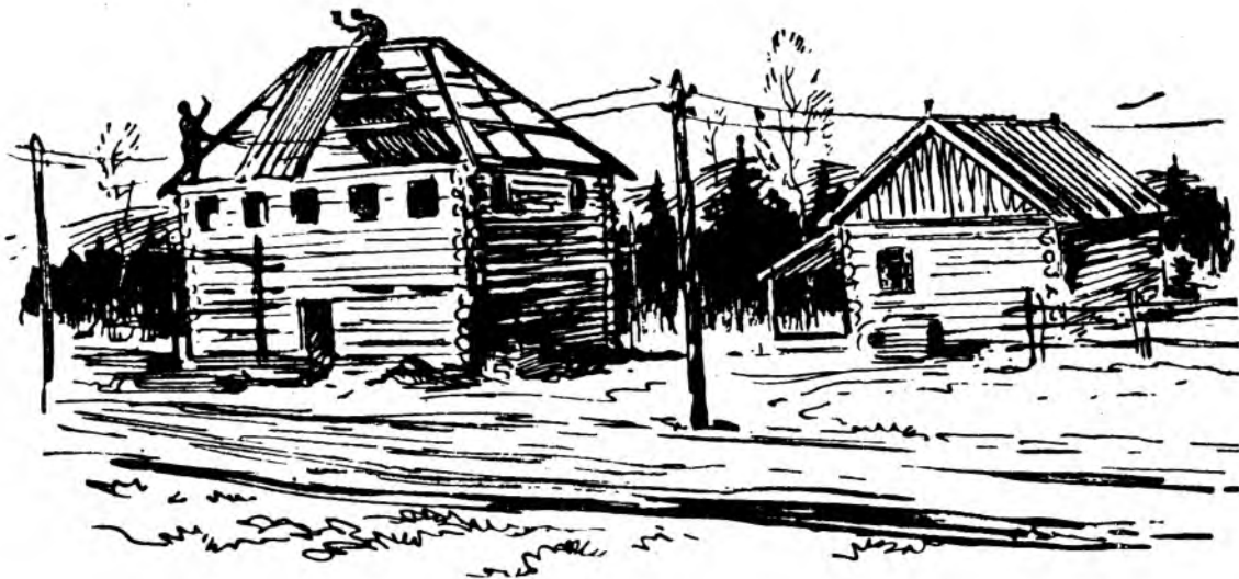
Строительство конторы промхоза в пос. Веселая Поляна.
